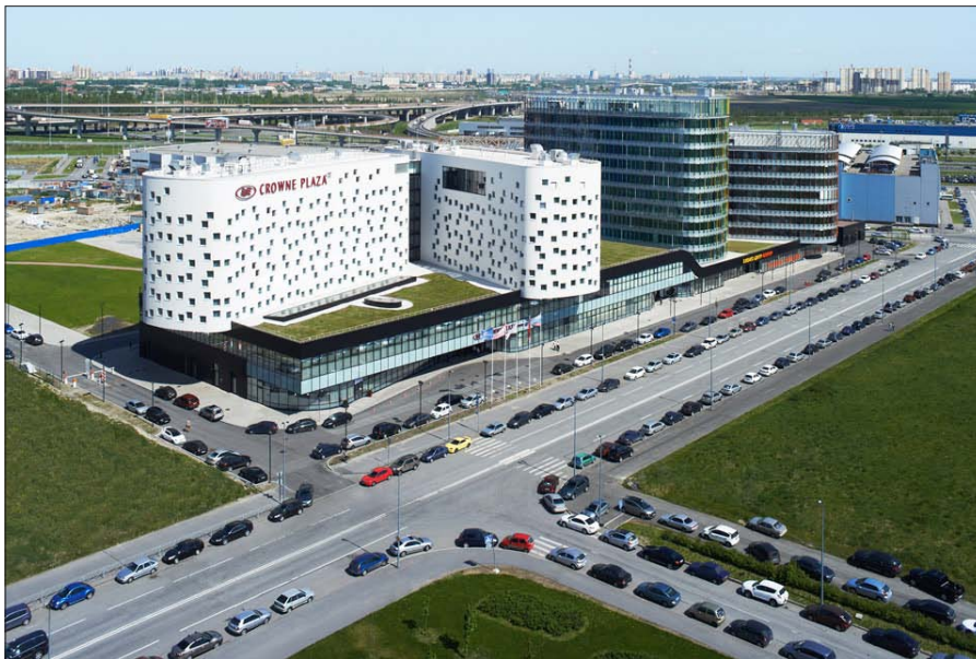
Airport City St. Petersburg – das Hotel Crowne Plaza und zwei der Bürogebäude.
