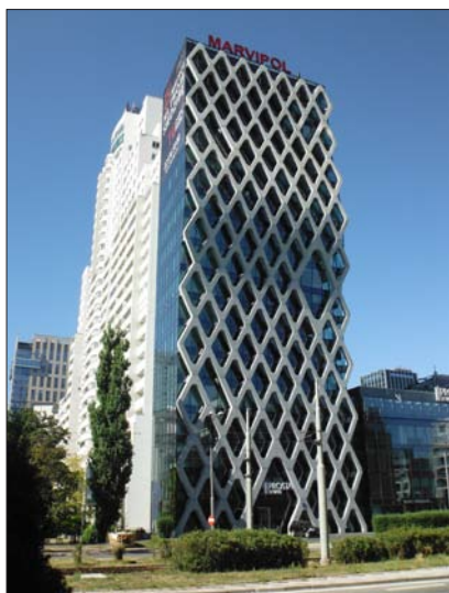
Prosta Tower in Warschau wurde von dem börsennotierten polnischen Unternehmen Mavripol entwickelt und bietet rund 6.000 Quadratmeter Mietfläche.
