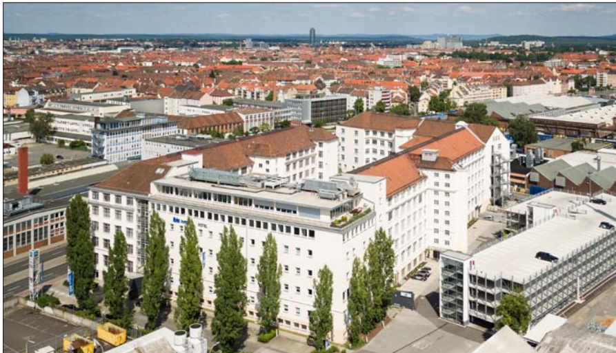
Eine 1920 errichtete Schuhfabrik in Nürnberg wurde als „Loftwerk“ revitalisiert.
