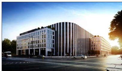
Sagittarius Business House in Breslau wechselte noch vor Fertigstellung den Eigentümer: Warburg-HIH Invest Real Estate erwarb das Projekt von Echo Investment.
