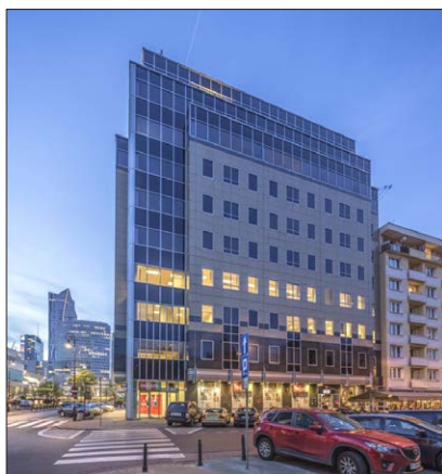
Das Warsaw Corporate Center wurde 1997 entwickelt. Das Bürogebäude mit Einzelhandel im Erdgeschoss liegt nahe dem Bahnhof Warszawa Centralna.
