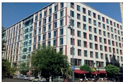
Das Bürogebäude Roosevelt am Szechenyi Platz in der Innenstadt von Budapest wurde 1980 errichtet, 2006 saniert und vor drei Jahren modernisiert.
