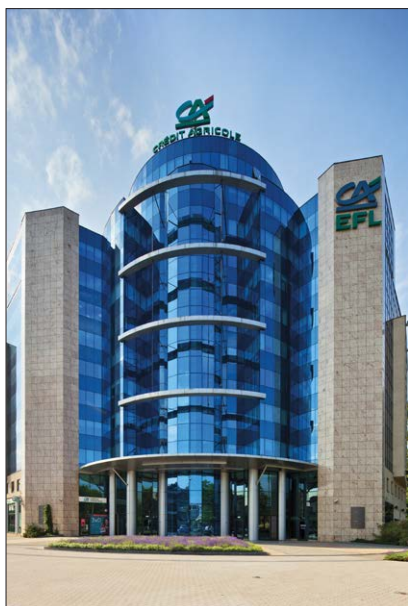
Centrum Orlat am Plac Lwowski in Breslau wurde 2002 entwickelt und war eines der ersten modernen Bürogebäude der Stadt. Bis Ende 2019 war Centrum Orlat Sitz der Crédit Agricole.
