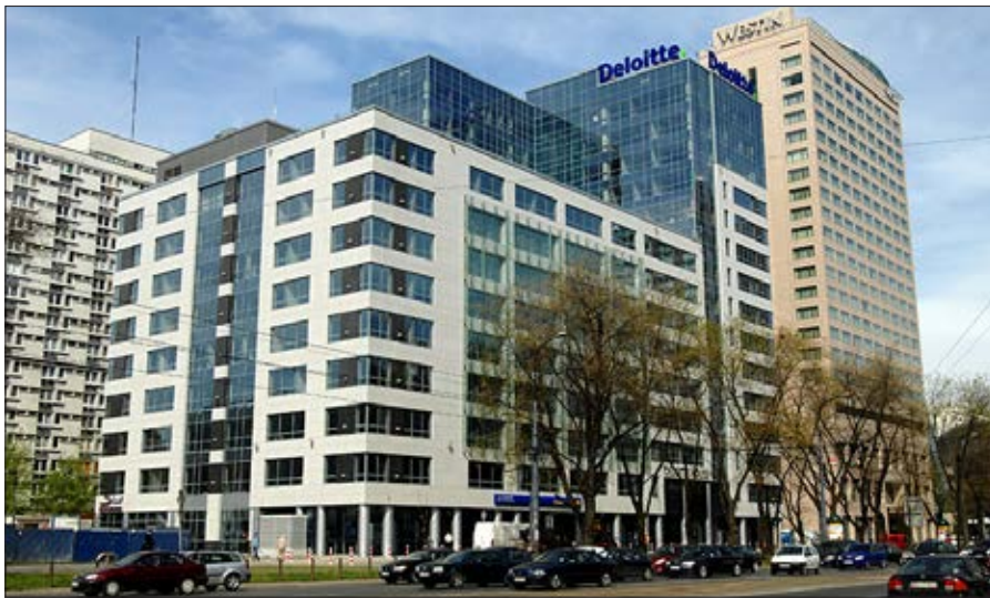
Das erste zertifizierte Green Building in CEE entwickelte Skanska in Warschau.
