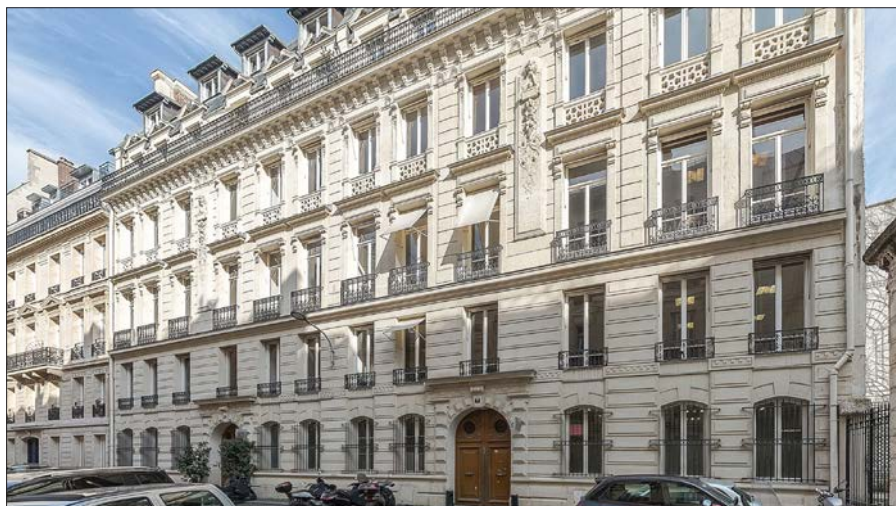
2021 erwarb Union Investment Real Estate das Bürogebäude in der Avenue du Coq.
