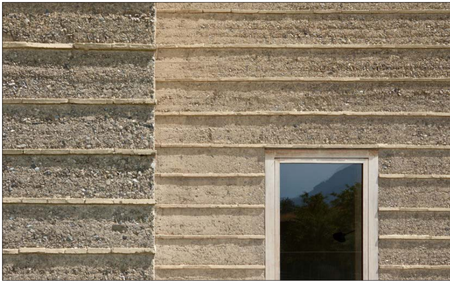
Horizontale Steinschichten schützen Lehmwände vor Erosion durch Regen.
