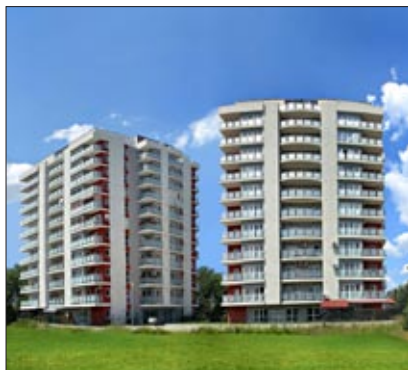
Das Wohnprojekt Edenia Titan in Bukarest: Hier wie auch bei dem Wohnprojekt Evocasa Optima hat Adama, ein Tochterunternehmen der Immofinanz Group, einen zweiten Bauabschnitt in Angriff genommen.
