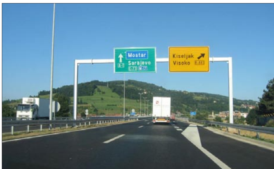
Das bereits fertiggestellte Stück der Autobahn 1 durch Bosnien und Herzegowina.
