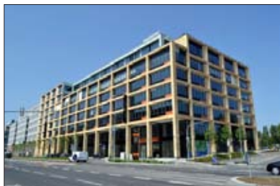
Der Bürokomplex River Garden ist das erste Projekt, das HB Reavis in Prag komplett fertiggestellt hat. Der erste Bauabschnitt war bereits 2012 eröffnet worden, jetzt folgten River Garden II/III.
