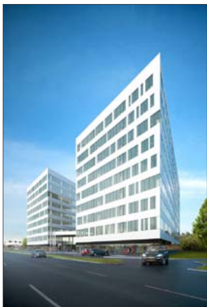
Der zweite Bauabschnitt von Kapelanka 42 in Krakau nähert sich seiner Fertigstellung. Die beiden neugeschossigen Bürogebäude umfassen insgesamt rund 30.000 Quadratmeter Bruttomietfläche.
