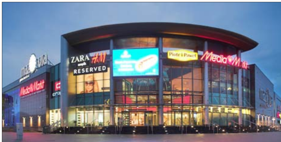
Neue Shopping Center entstehen vor allem in Städten unter 200.000 Einwohnern.
