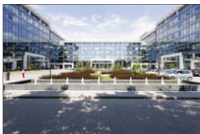
Der T-Mobile Office Park im Warschauer Bezirk Mokotów ist eines der drei Bürogebäude, die Starwood Capital von Ghelamco erworben hat.
