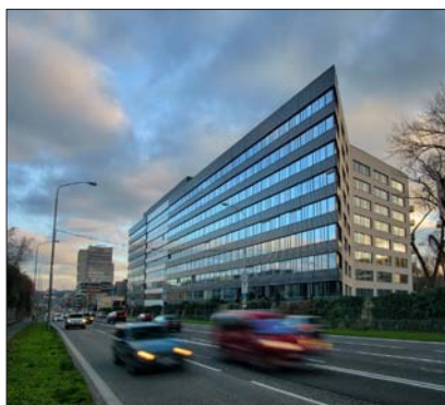
Westend Gate in Bratislava wurde von J&T Real Estate entwickelt und verfügt über 35.000 Quadratmeter Bürofläche.
