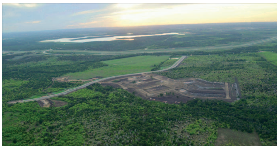
Oben die sanierte Siedlung in Rotenburg (Wümme), unten das Areal für den ersten der vier Bauabschnitte in Whisper Valley.
