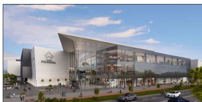
Galeria Północna in Warschau soll 2017 eröffnen. Jetzt wurde der Grundstein für das Shopping Center gelegt.
